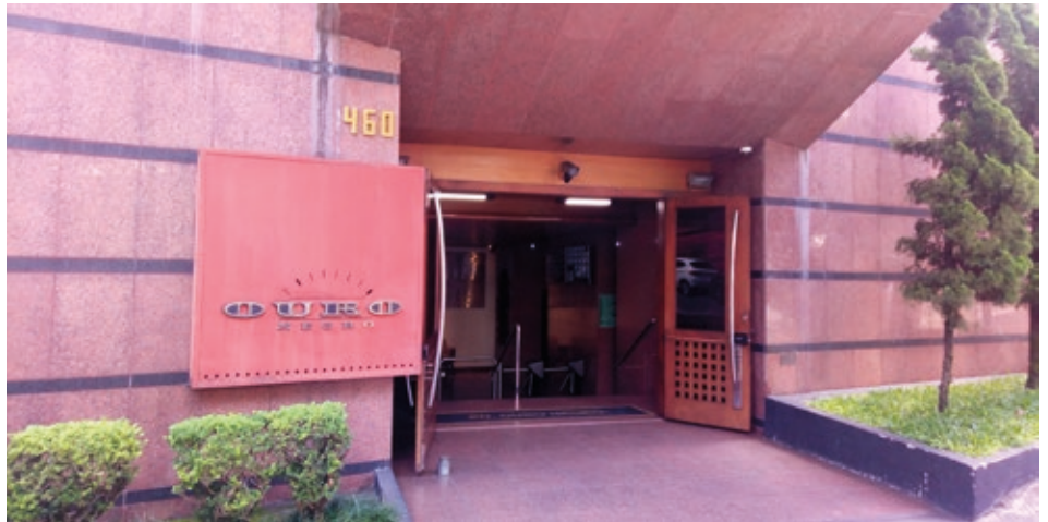
Fachada do Edifício Ouro Negro, no bairro Santo Antônio, em Belo Horizonte, antigo local de atendimento da AMS na capital mineira
