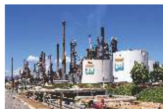
Fotos: Banco de Imagens da Petrobrás. Da esquerda para a direita: (1) construção da Regap; (2) vista aérea da Regap; (3) inauguração da refinaria; (4) Regap atualmente.
