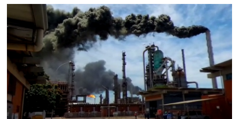
Falta de ar comprimido causou descontrole na unidade de craqueamento da Replan, em SP
